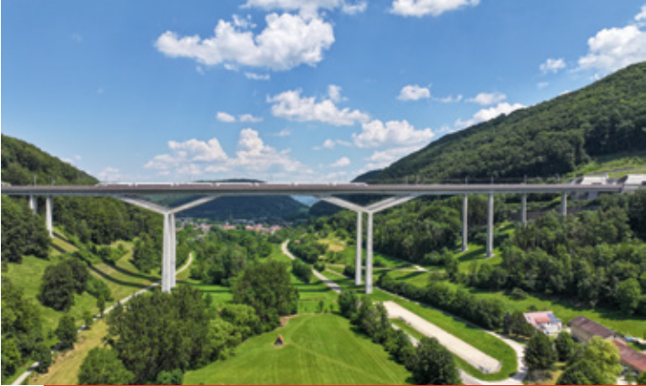
Filstalbrücke bei Mühlhausen
