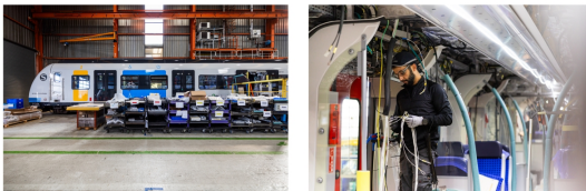
Die Serienumrüstung der Baureihen 423 und 430 ist in vollem Gang, u. a. im Alstom-Werk in Villeneuve. Inzwischen sind mehr als 80 Triebzüge umgerüstet und werden wieder im Fahrgastbetrieb (noch ohne ETCS) eingesetzt.
