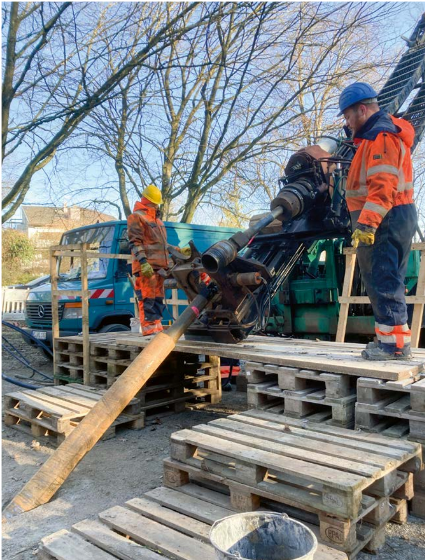
Kein erfolgreicher Tunnelvortrieb ohne gut vorbereitete Vorabbohrungen: Die Gesteinsproben (oben rechts) wurden dem Erdreich am Westrand von Leinfelden genommen.
