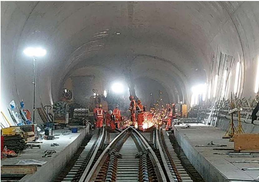
Vom Tunnelvortrieb über die Innenschale zum Gleisbau – ein Anschlussstutzen im Wandel der Zeit.
