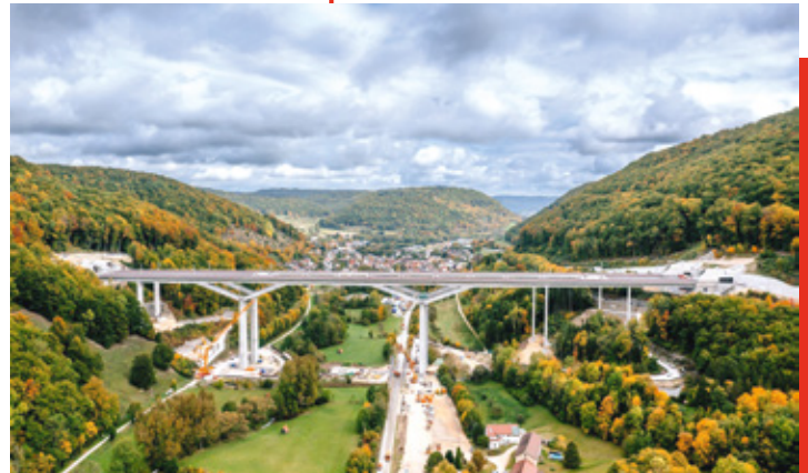
Filstalbrücke bei Mühlhausen
