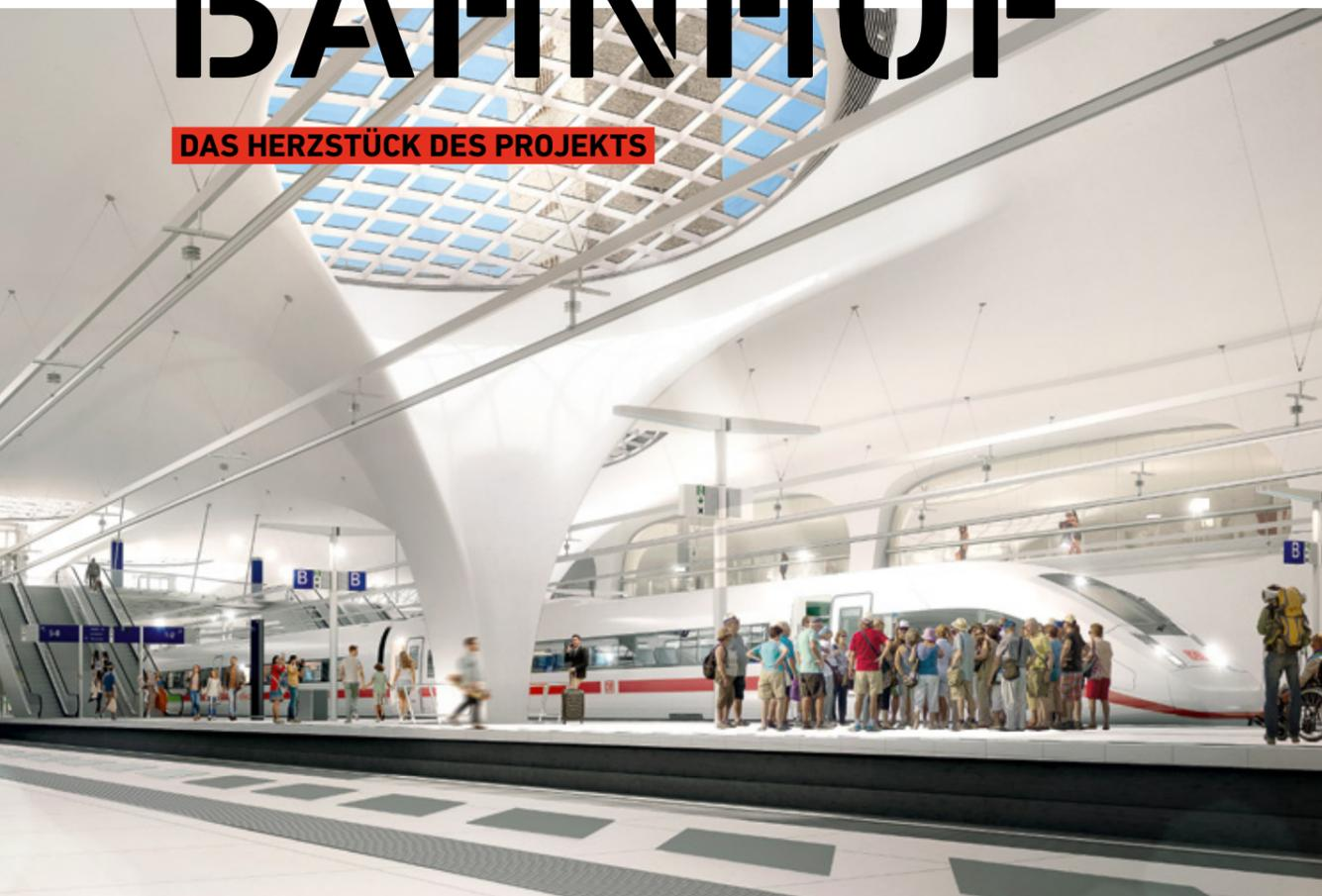
DER NEUE STUTTGARTER HAUPTBAHNHOF LIEGT QUER ZU DEN HEUTIGEN GLEISEN IN ETWA ELF METERN TIEFE. ER HAT ACHT GLEISE AN VIER MITTELBAHNSTEIGEN. DIESE SIND JEWEILS 420 METER LANG.
