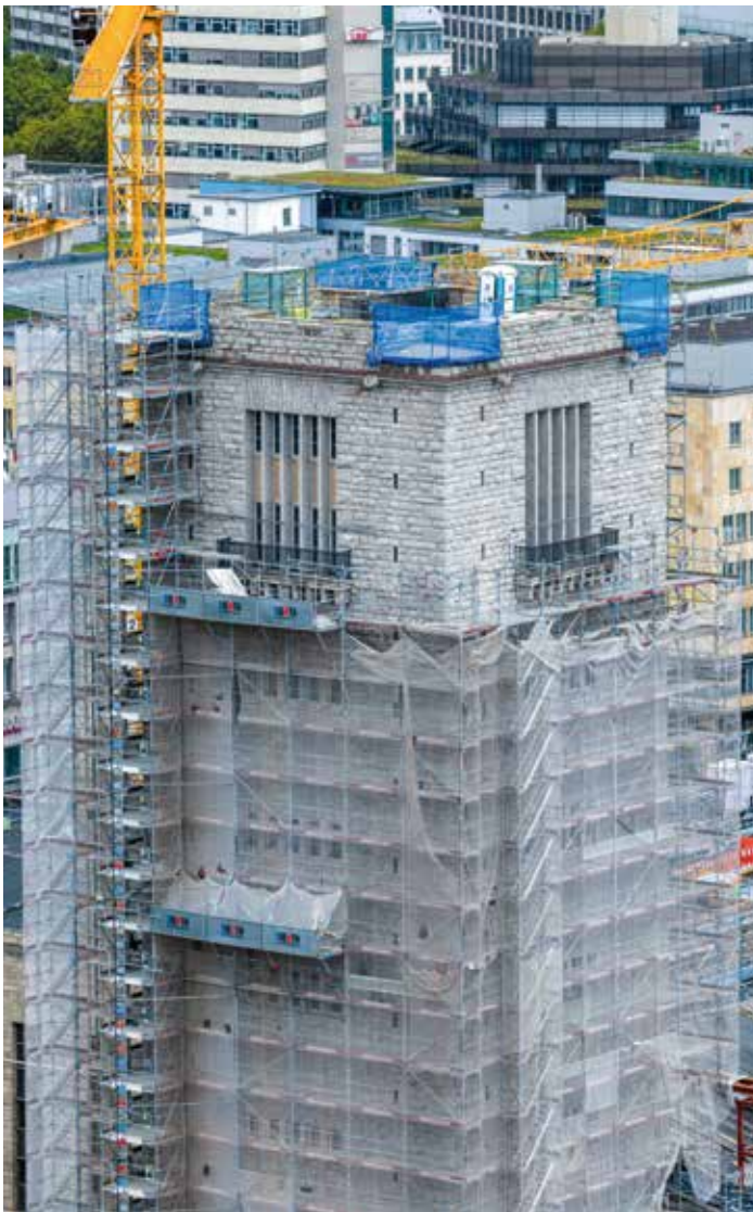
Die Muschelkalkblöcke der Turmfassade sind geprüft, gereinigt, repariert. Daher wird das Gerüst nicht mehr gebraucht und nach und nach abgebaut.
