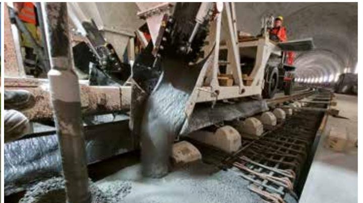
Auf Schienen kamen die Schienen (unten links). Nach Montage, Grobausrichten und Feinausrichten fließt der Beton für die Feste Fahrbahn der künftigen Verkehrsdrehscheibe für Baden-Württemberg.
