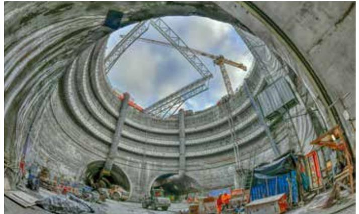
Der große Schacht aus Zeiten des Tunnelvortriebs (unten rechts) ist bis auf den Aufzugsbereich gefüllt. Derzeit entsteht das überirdische Gebäude des Zugangs Ost (unten links).
