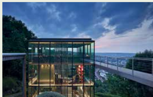
Wohnhaus R128 Stuttgart
