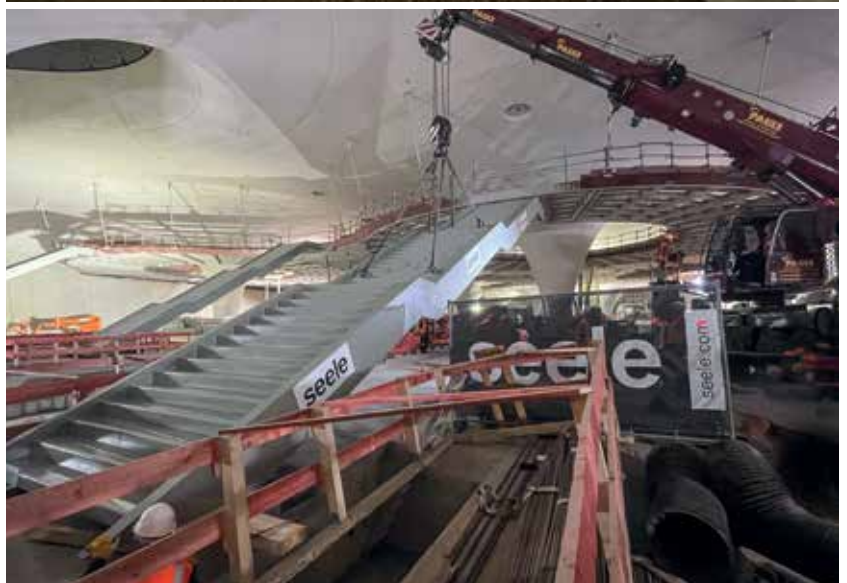
Der Einbau der Treppen zu den Bahnsteigen erfordert Millimeterarbeit – beim Rangieren des Tiefladers, beim Abladen, und wenn eine der Treppen am Kranhaken hängt.
