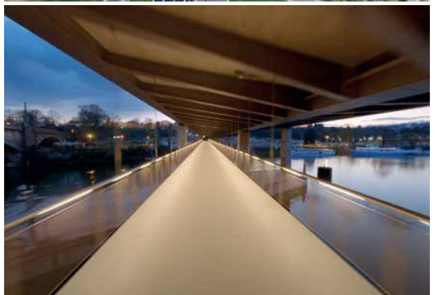
Die drei großen Überführungen von Stuttgart 21 – anders als die Brücken übers Sulzbachtal und über die B 313 bietet die Neckarbrücke bereits heute Radlern und Fußgängern die Möglichkeit, zur anderen Seite zu gelangen (unten).
