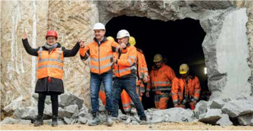
Tunnelpatin Carla Werthwein mit den Mineuren beim Tunneldurchschlag.
