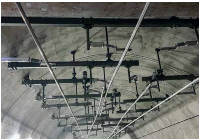
Auf den Fildern (ganz oben) und in fast allen Tunneln liegen die Gleise. Darauf folgt der Bau der Oberleitungen. In den Röhren werden zunächst die Halterungen für die Deckenstromschienen montiert, in denen der Fahrdrabt geführt wird.
