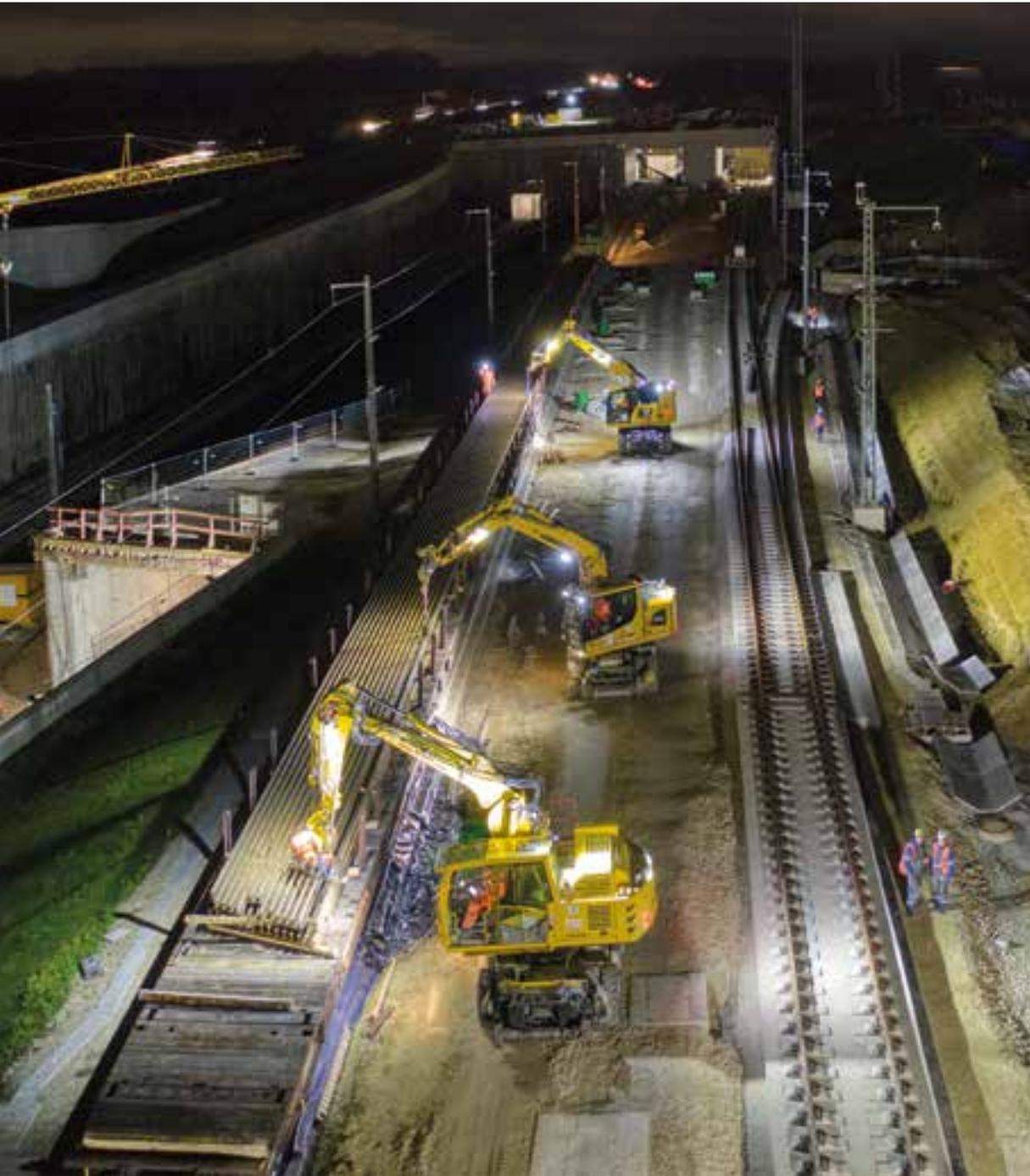
Ballett der Bagger: Bei Wendlingen werden 120 Meter lange Schienen von den Waggons gezogen [2021]
