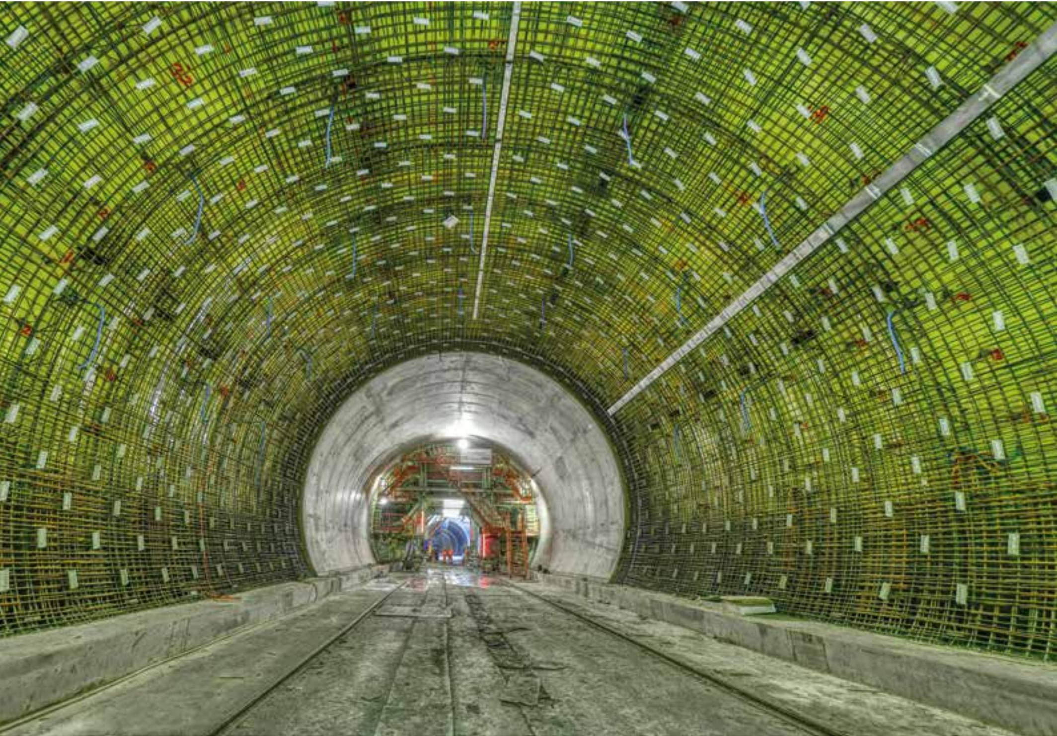
Schrittweiser Einbau der Innenschale im Flughafentunnel [2022]
