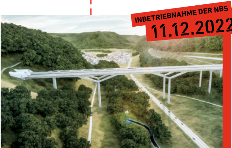
Filstalbrücke bei Mühlhausen
