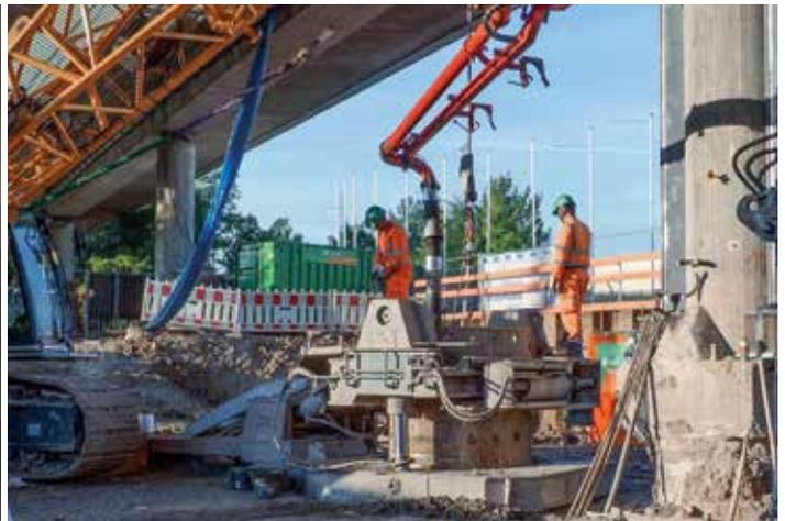
Vor der Betonage eines Hilfspfahls (unten rechts) müssen bis zu einer Tiefe von 20 Metern Aushub beseitigt und Bewehrungsstahl eingebaut werden.
