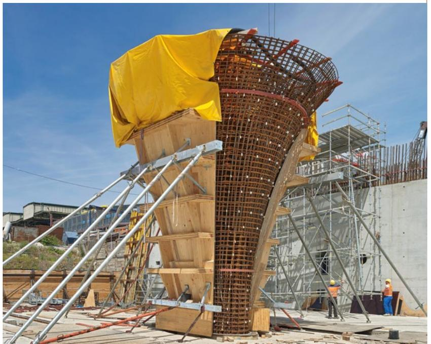
Für die erste Kelchstütze wurde die Lage der Stäbe in einer virtuell begehbaren Bewehrung überprüft (oben). Zwischen 24 und 37 Ramppfähle braucht es als Fundament (Mitte), ehe ein sechs Meter hoher Kelchfuß daraufgesetzt wird.
