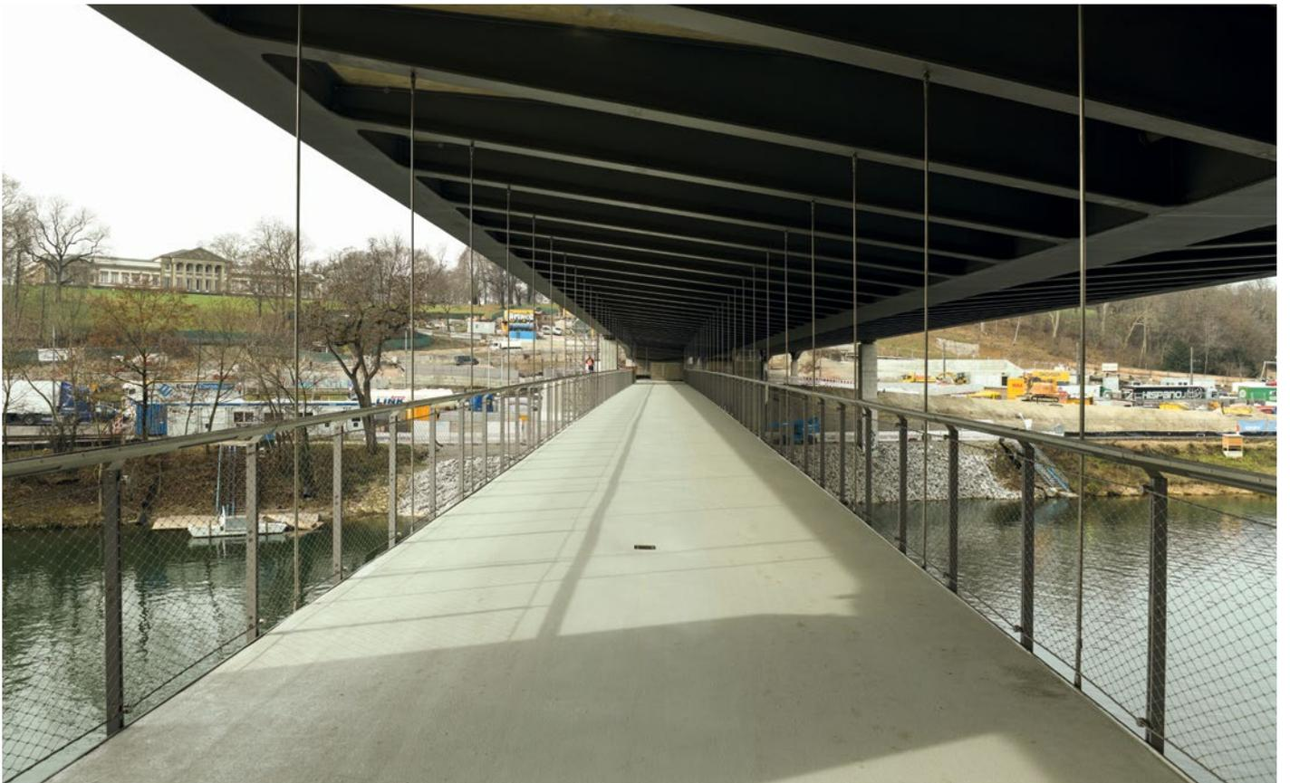
Oben wird die Brücke später von Fernzügen befahren, darunter, auf einem viereinhalb Meter breiten Hängesteg, können Fußgänger und Radler schon jetzt den Neckar zum Rosensteinpark überqueren.
