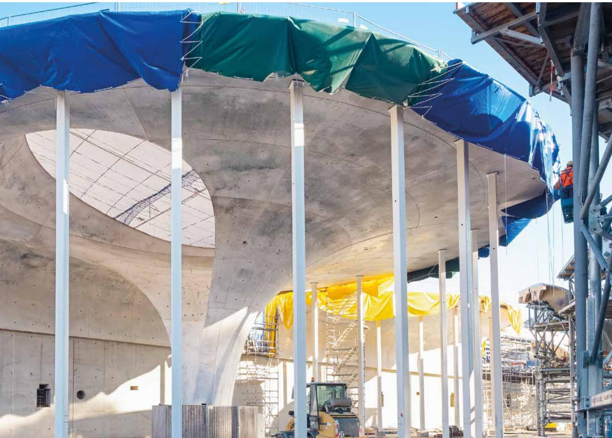
**Bis die betonierte und ausgeschaltete Kelchstütze im Verbund mit den Nachbarkelchen ihre Tragwirkung entfalten kann, braucht es mehrere Behelfsstützen [2018]**
