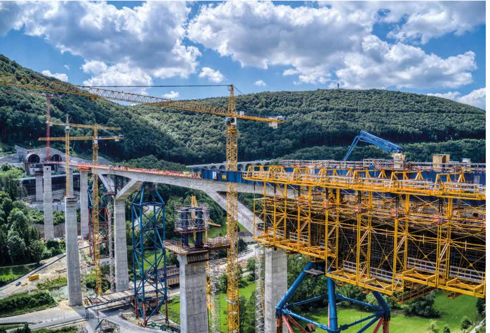
Die gelbe Vorschubrüstung an der Filstalbrücke startet am Portal des Boßlertunnels für den Bau des nördlichen Brückenelements [2020]
