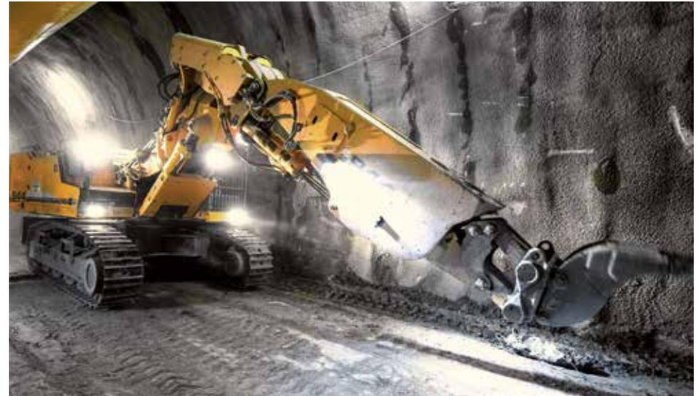
Raupenbagger mit speziellem Tunnel-Schwenkarm und Reißzahn [2016]
