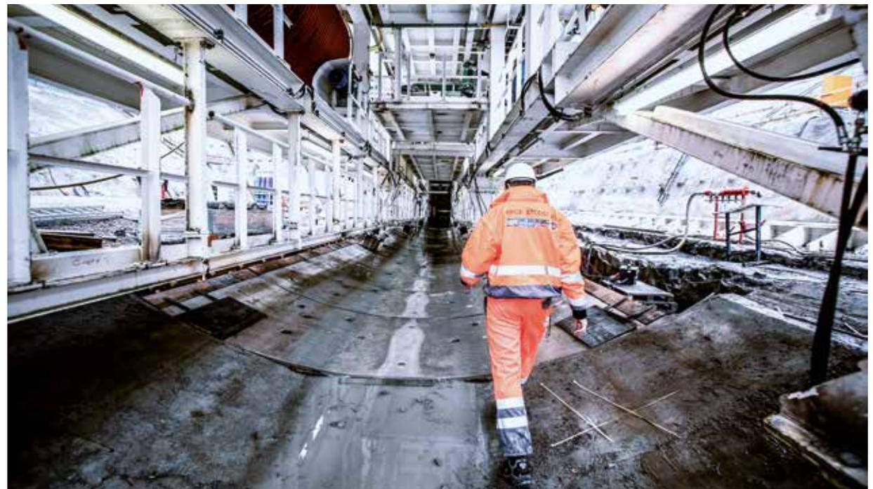
Mehr als 100 Meter lang ist eine Tunnelbohrmaschine. Da fallen weite Wege an [2016]
