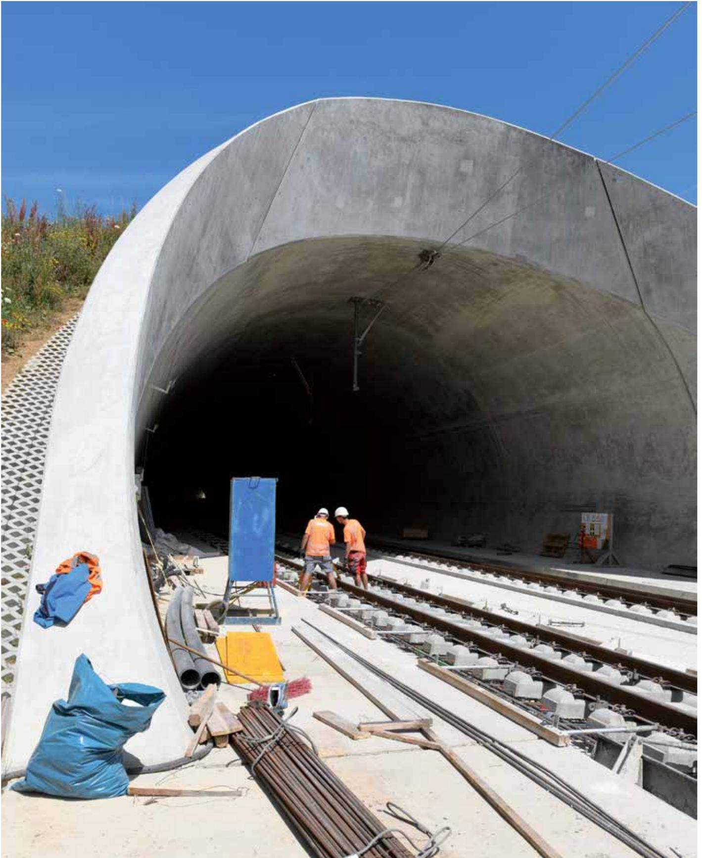
In Summe müssen auf dem 60 Kilometer langen Abschnitt der Neubaustrecke 120 Kilometer Gleise verlegt werden, die Hälfte davon in insgesamt zwölf Tunneln unterschiedlicher Länge, wie hier am Tunnel Imberg. Dazu kommen noch 24 Weichen und die Errichtung von Anlagen für die Telekommunikation und den Bahnstrom.
