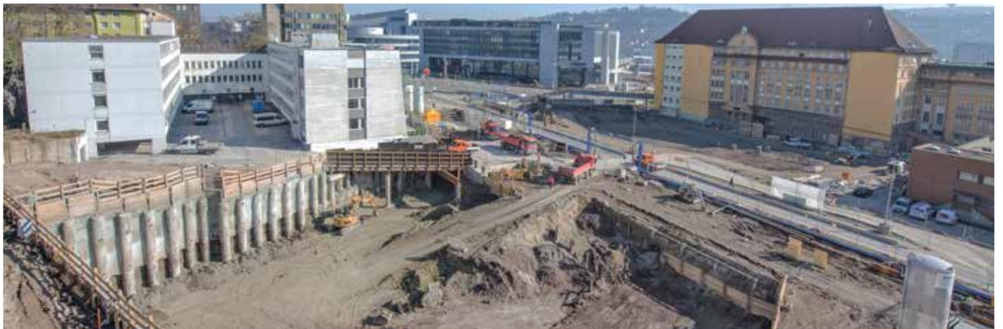
Um den Tunnel Nordkopf bauen zu können, wurde bis zu elf Meter tief ausgehoben, die ehemalige Bahndirektion aufwendig unterfangen und ein Stadtbahntunnel freigelegt (oben). Das Quartier rund um die Bahndirektion (links Mitte), bevor 2012 der nicht denkmalgeschützte Teil der Bahndirektion abgebrochen wurde (rechts Mitte). Beginn des Aushubs links und rechts der Jägerstraße (unten).
