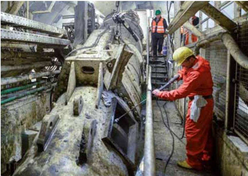
Angetrieben von 13 Motoren, die es auf 6.200 Pferdestärken bringen, fräst sich der Bohrer mit einem Durchmesser von 11,39 Metern durchs Gestein.
