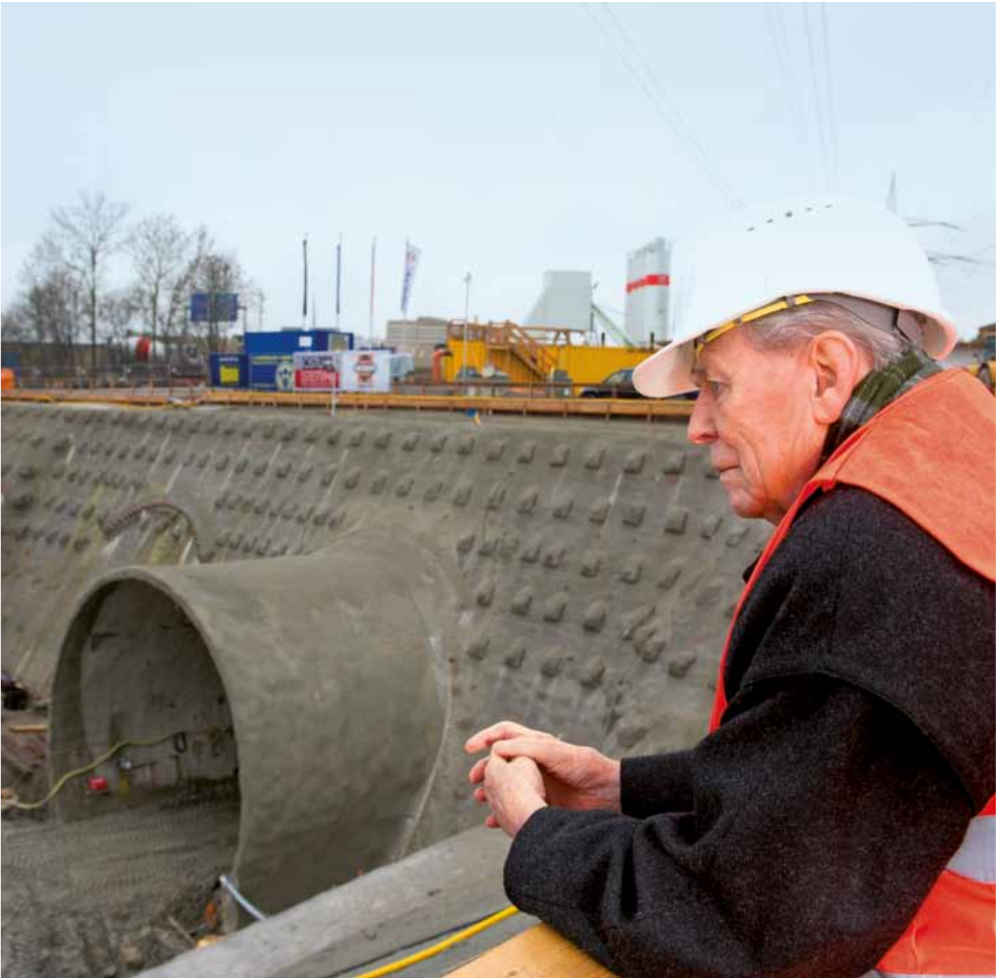
Nachdenklicher Vordenker: der Eisenbahnprofessor auf der Baustelle am Fasanenhof.
